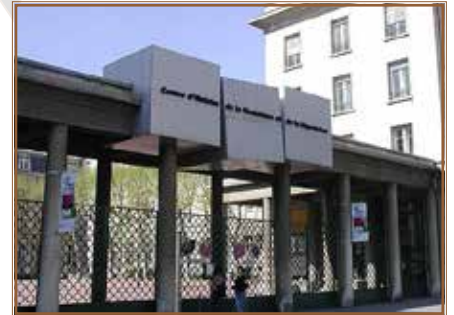
Entrée actuelle du Centre Berthelot reconstruite en 1962. DR
